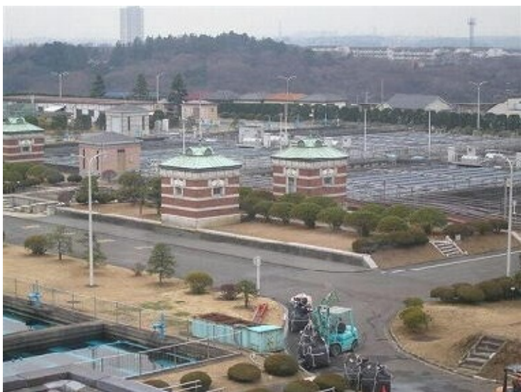
3 西谷浄水場構内（同上）
