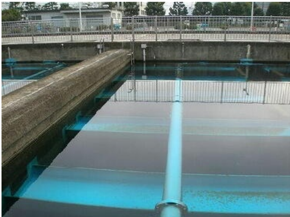
9 配水地（完成した水道水）
